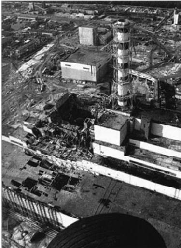
*Bild 2: Das Arbeitsfeld 1 – Dach des Maschinensaals (im Vordergrund). In der Nähe des Entlüftungsrohrs sieht man die Dächer der Gebäude, wo die Feuerwehr des 2. Arbeitsfeldes gearbeitet hat (rechts vom Rohr sieht man das Dach des Reaktorsaals Block 3).*
