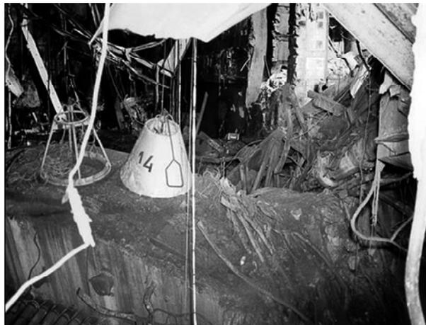
**Bild 13: Großaufnahme von Schema "E". Auf diesem stehen konische Sensoren, die für die Kontrolle der Umwelt installiert sind.**
