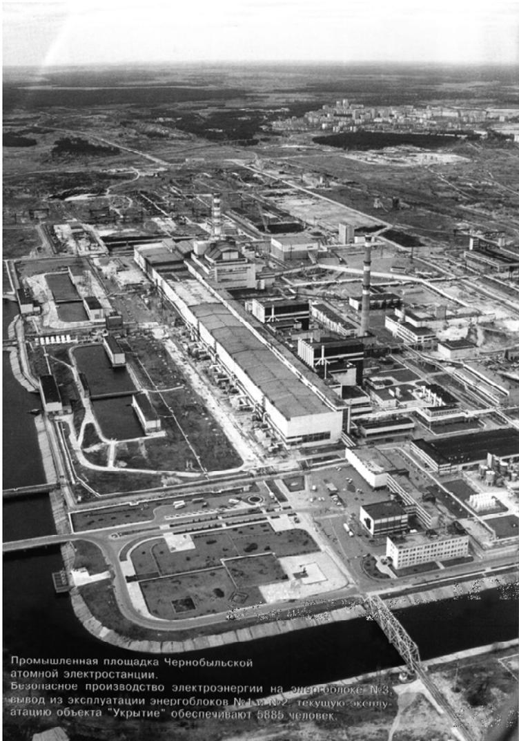
***Bild 9: KKW Tschernobyl. Im Vordergrund langes Gebäude des Maschinensaals. Dahinter sieht man das schwarze Gebäude der Reaktorabteilung. Hinter dem linken Flügel des Maschinensaals sieht man das Doppelgebäude der Kraftwerkblöcke 3 und 4 mit dem Entlüftungsturm (150 m hoch) in der Mitte. In der rechten oberen Ecke ist die Stadt Pripjat' sichtbar.***
