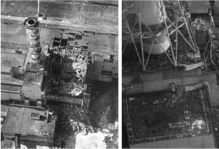
***Bild 3 und 4: Teil des 2. Arbeitsfeldes, das Dach neben dem Block 4. Sichtbar sind Teile der aktiven Zone, die bei der Explosion auf das Dach von Block B, wo das Entlüftungsrohr steht, herausgeschleudert wurden. Die Ansicht ist von der Nordseite gegeben: rechts befindet sich (und ist auf dem linken Bild zu sehen) der zerstörte Reaktorsaal von Block 4, links – das Dach vom Reaktorsaal des 3. Blocks. Auf dem rechten Bild – Großaufnahme von einem der Dächer).***
